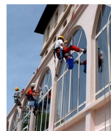
Nettoyage en hauteur
